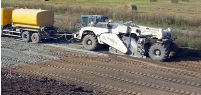
Stabilisatrice de sol et réservoir d'eau
